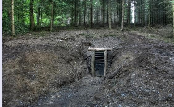
Die obere Sohle verfügt über einen separaten Zugang, welcher aber mit Erdrich verschüttet wurde. Über einen kleinen Schacht im Inneren waren die beiden Stollen miteinander verbunden (Überbruch).
